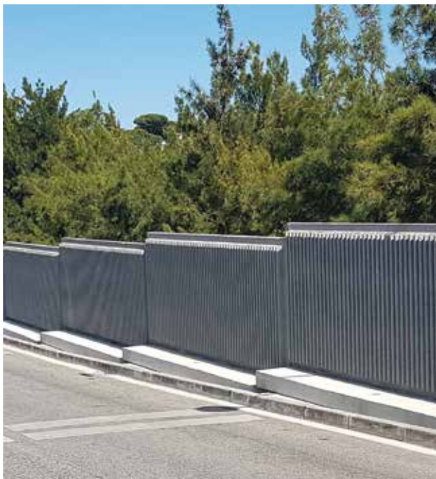
Via Longitudinal Norte - Cascais | 2022
